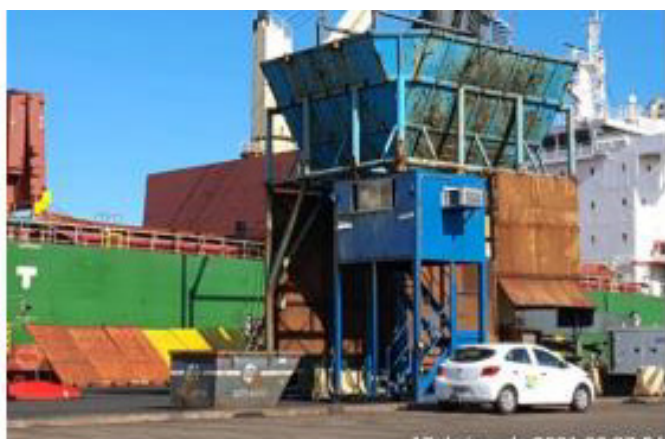
Utilização de barreiras de proteção no costado dos navios e moegas para evitar a queda de material particulado.
