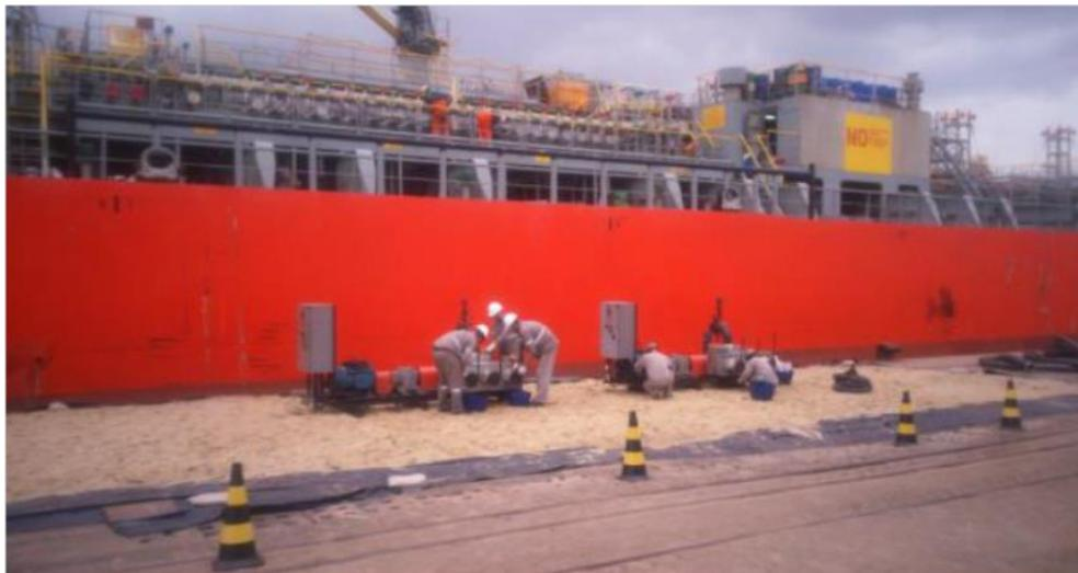
Foto 2: Kits em montagem sobre camada de areia de contenção e lona plástica.
