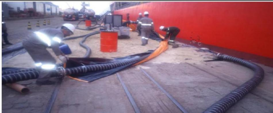
Foto 4: Encapsular mangote com lona adaptada com velcro.
