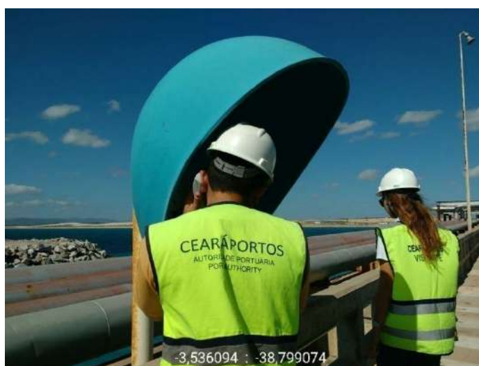
Figura 13 – Orelhões de emergência para contato direto com o CCO da CIPP S.A.
