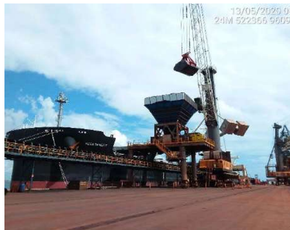
Figura 12 – Guindaste sobre trilhos e esteira tubular transportadora – Píer 1.
