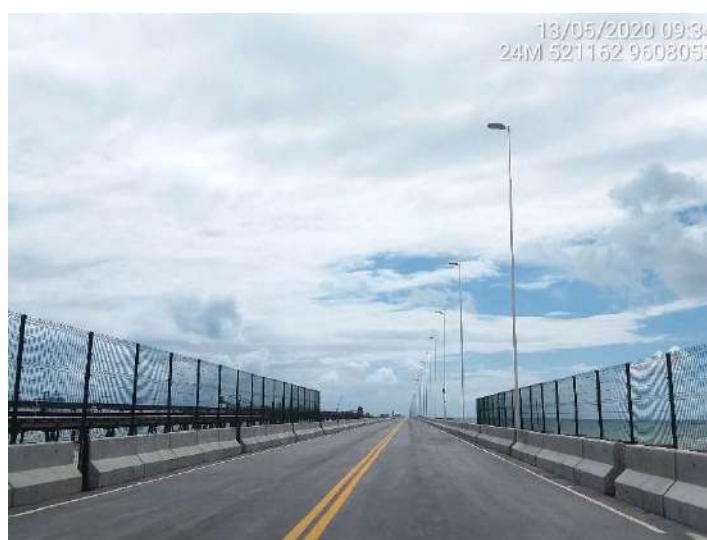
Figura 2 – Ponte de Acesso 2.
